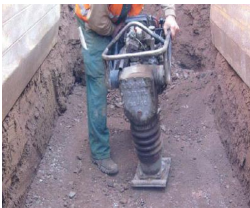
Slika 1 i 2: Priprema podloge za polaganje šahtova
