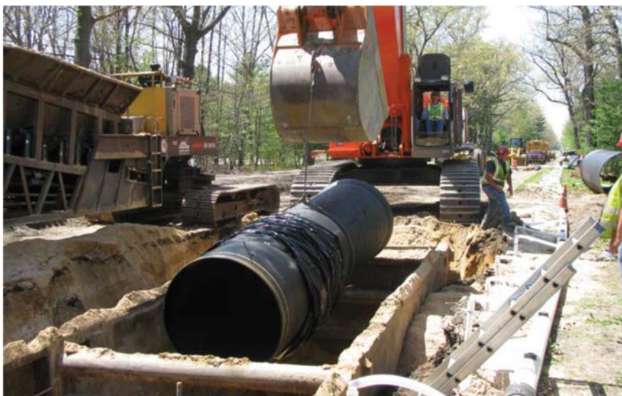
Slika 3: Upotreba tekstilne trake za rukovanje cijevima
