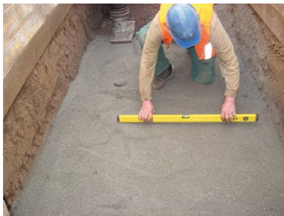
Slika 1 i 2: Priprema podloge za polaganje šahtova
